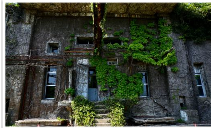
佐世保無線電信所(針生送信所) 無銭湯中央の電信室 大正11年完成
